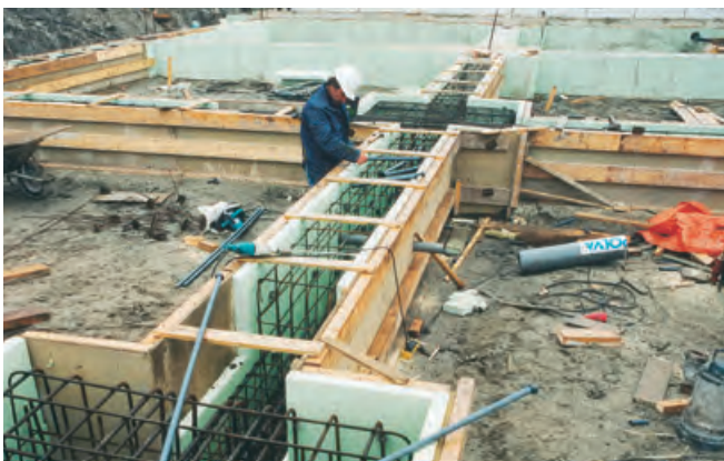
Abb. 25: Schalung mit Styrodur® C.
