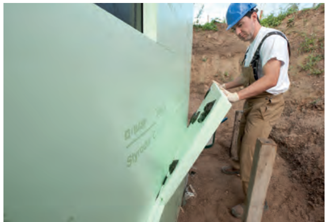
Abb. 5: Punktweise Verklebung der zweiten Lage Styrodur-Platten mit Stufenfalz und versetzten Fugen.
