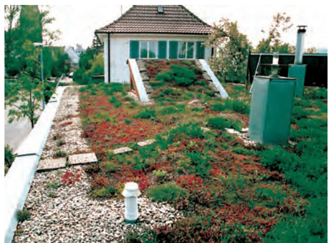
Abb. 66: Kiesstreifen am Dachrand und an Dachdurchdringungen.
