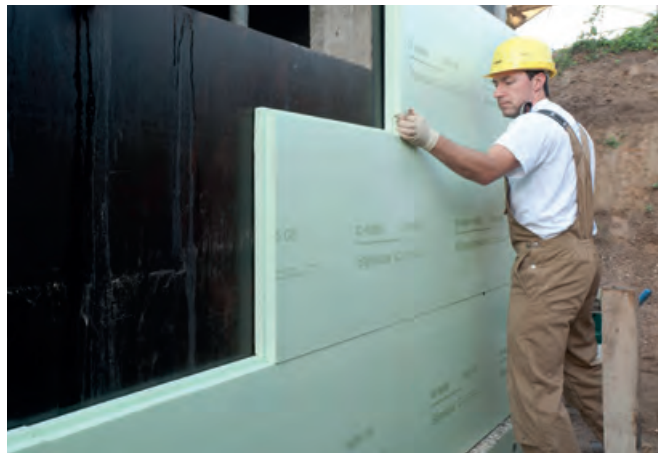
Abb. 4: Dichtgestoßene Styrodur®-Platten sorgen für eine wärmebrückenfreie Perimeterdämmung.
