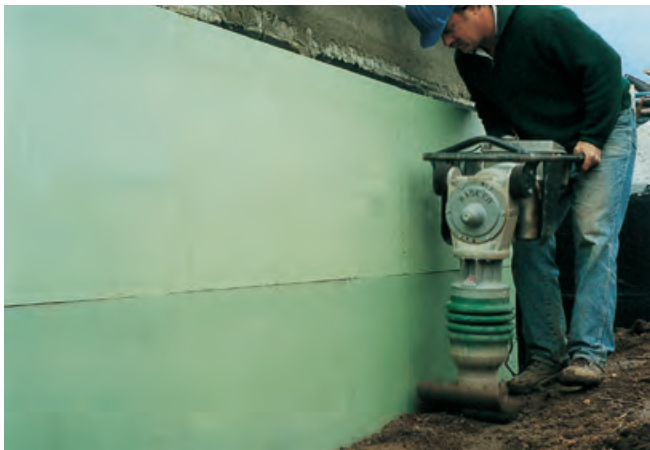
Abb. 28: Lagenweise Verfüllung der Baugrube und mechanische Verdichtung.
