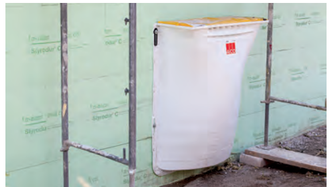
Abb. 22: Lichtschachtmontage bei Perimeterdämmung
