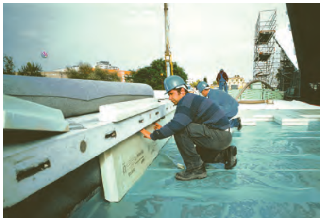
Abb. 44: Attika-Dämmung mit Styrodur.
