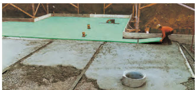
Abb. 6: Sauberkeitsschicht aus Magerbeton zur Verlegung der Bodendämmung.
