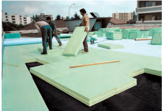
Abb. 43: Verlegung von Styrodur® beim Duodach.
