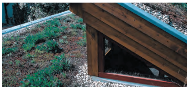
Abb. 57: Extensive Dachbegrünung mit trockenresistenten Pflanzen.
