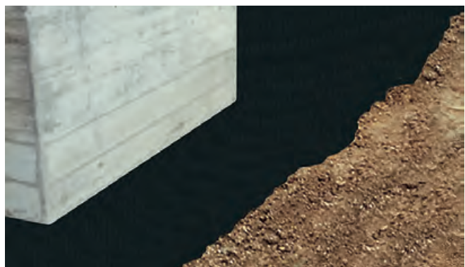
Abb. 15: Abdichtung der Kellerwand gegen drückendes Wasser.
