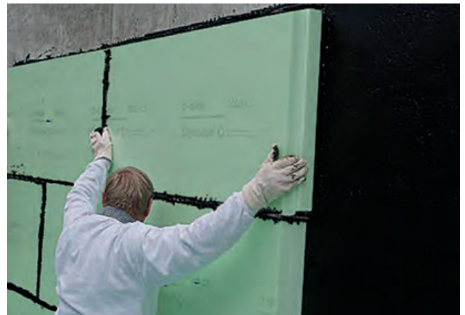
Abb. 17: Ansetzen der Styrodur®-Platten und Verspachteln der Fugen gegen drückendes Wasser.
