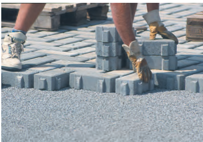
Abb. 78: Verbandverlegung eines Betonpflasters mit Grasfugen für einen Parkplatz auf einer Schulsporthalle.
