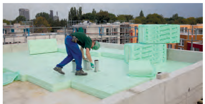
Abb. 33: UK-Dach-Dämmung mit Styrodur® von 250 Wohneinheiten in Hamburg.
