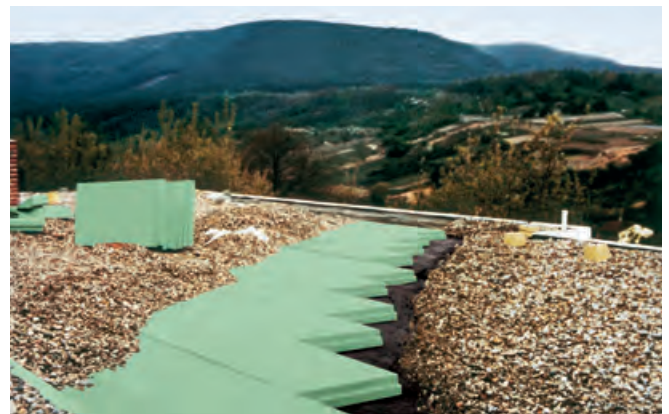
Abb. 47: Saniertes UK-Dach als Plusdachkonstruktion.
