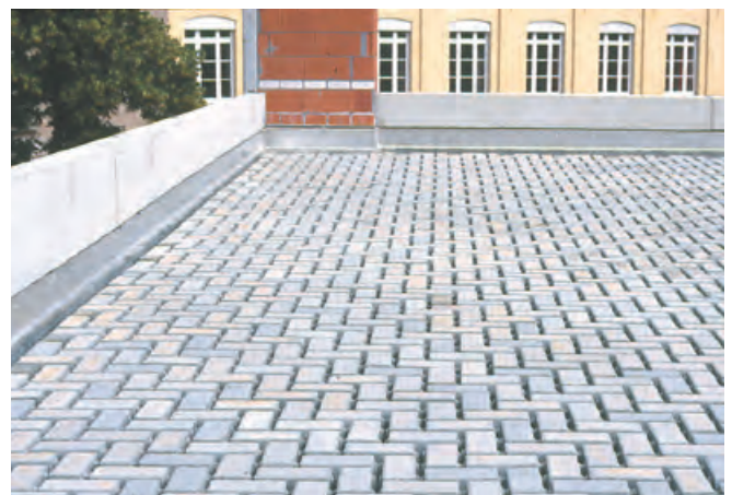
Abb. 79: Verlegtes Betonpflaster auf Styrodur®.
